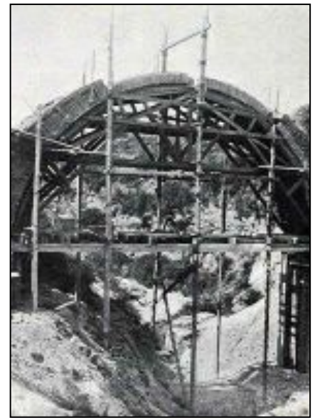
Pont dels Bruchs
